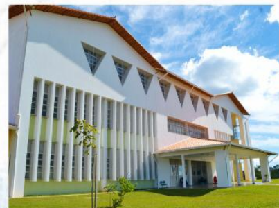
Biblioteca UFVJM - Campus JK (futuras instalações do Centro de Projetos - 3º andar)
