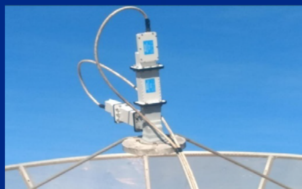
Imagem 05 - Antenas parabólicas com filtro 5G para mitigação de interferências
