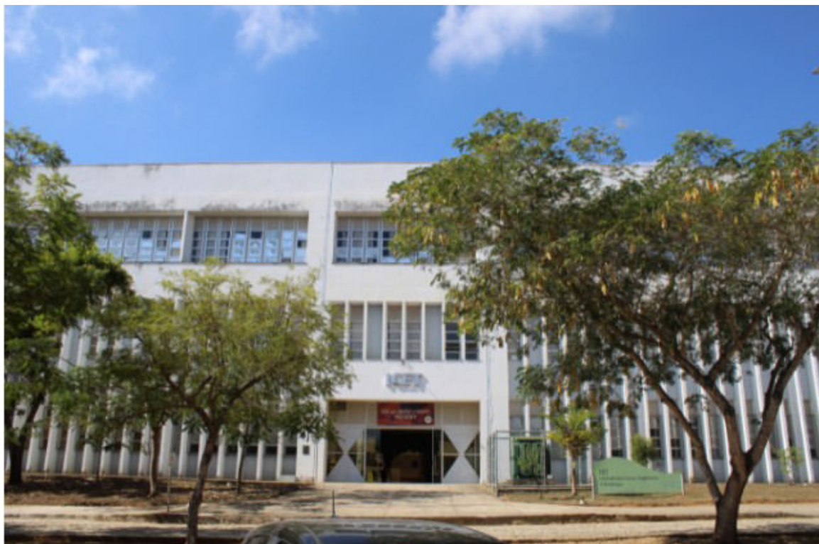
Figura 1: Prédio do ICET
