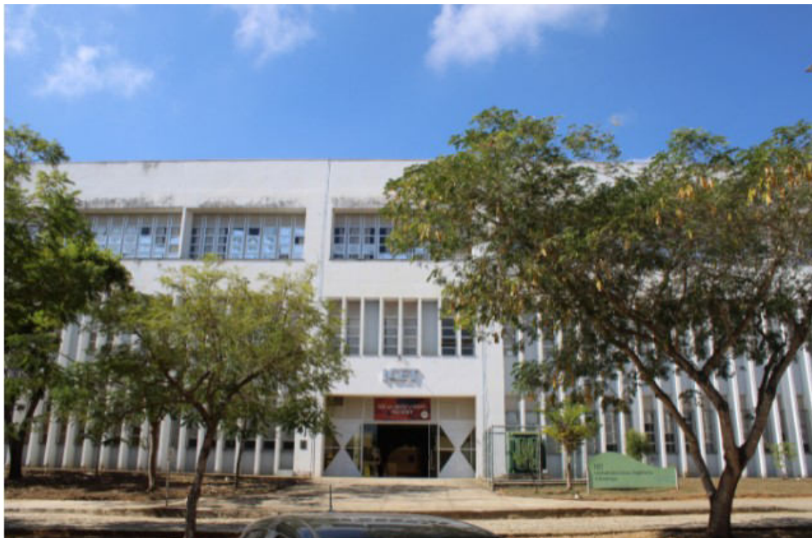
Figura 1: Prédio do ICET
